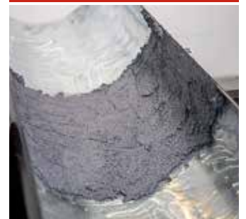
DUCTOS Y TUBERÍAS
