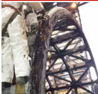
RECUPERACIÓN Y PROTECCIÓN
